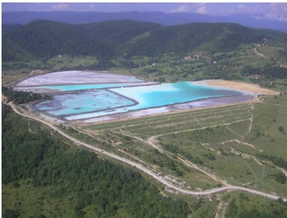
Slika 6.1 Odlagalište pepela i šljake na Maljevcu
