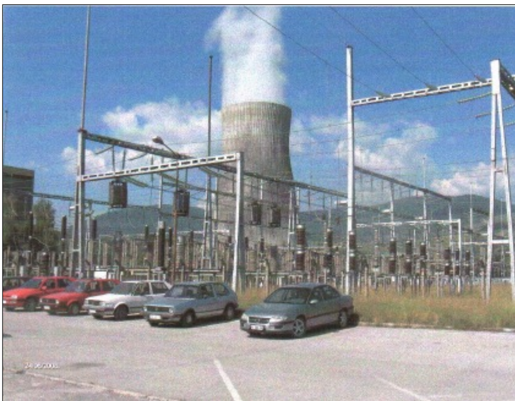
Slika 1.93 Transformatori ispred TE Pljevlja I
