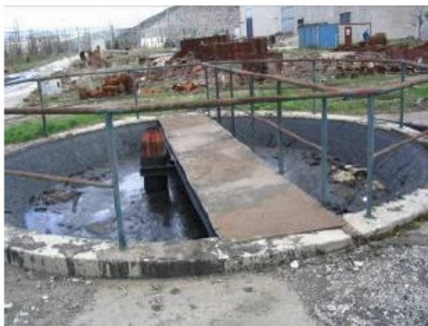
Slika 1.67 Lokacija za spaljivanje zauljenog otpada - Izvor: Environmental Site Assessment - ESA) „TE Pljevlja“, Dekonta d.o.o. 2006.
