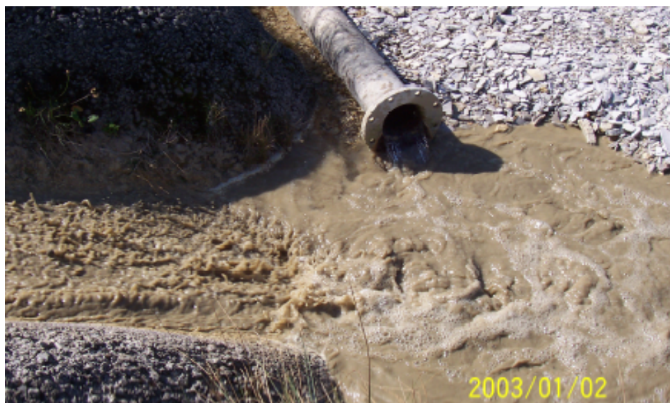
Slika 1.81 Drenaža voda sa deponije Maljevac
