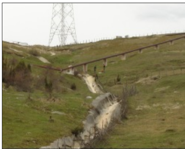
Slika 1.77 Preliv sa brane i drenaža
