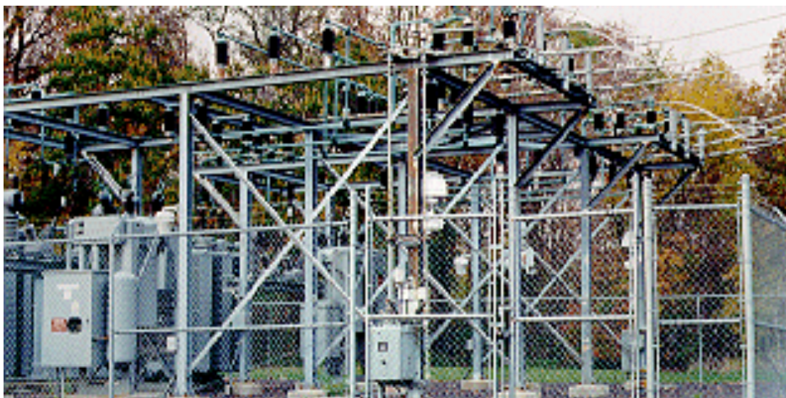
Slika 1.92 Električne centrale- trafostanice
