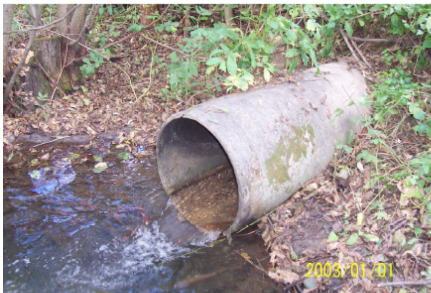
Slika 1.78 Ispust sanitarnih voda u Vežišnicu
